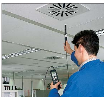
Měření koncentrace CO 2 na přívodních a odvodních klimatizačních nebo odvětrávacích kanálech
