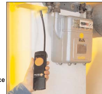
Kontrola těsnost na domovních rozvodech
